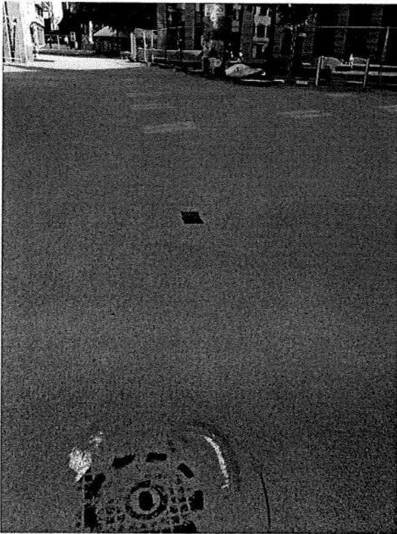
Beim Einbau der neuen Granulatdecke gelangt loses Material direkt in die Kanalisation. Aufnahmen vom 2. Juni 2020
